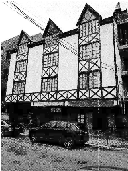
Fachada sobre Deloqui
