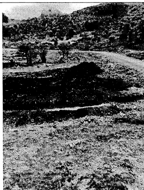
Foto 23: Vista de drenaje junto a módulo de Relleno Sanitario.
