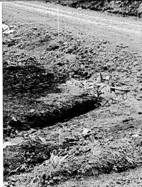
Foto 22: Vista de drenaje junto a módulo de Relleno Sanitario.
