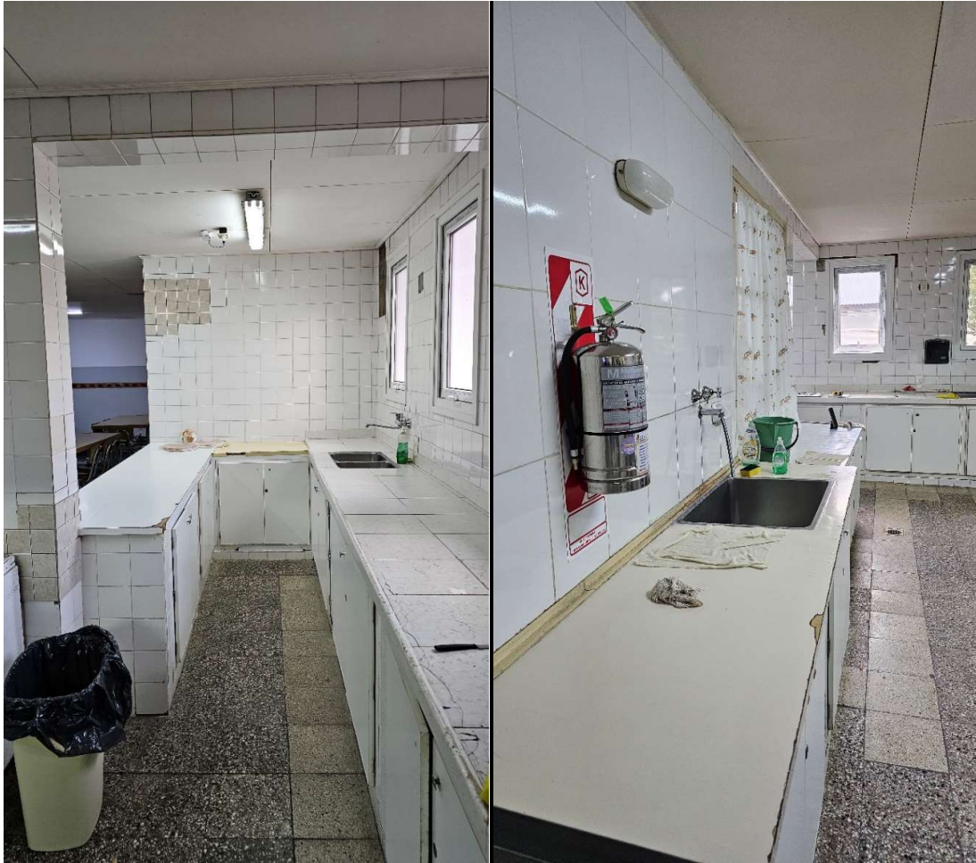
Fotos de la cocina de Copa de Leche a reformar:
