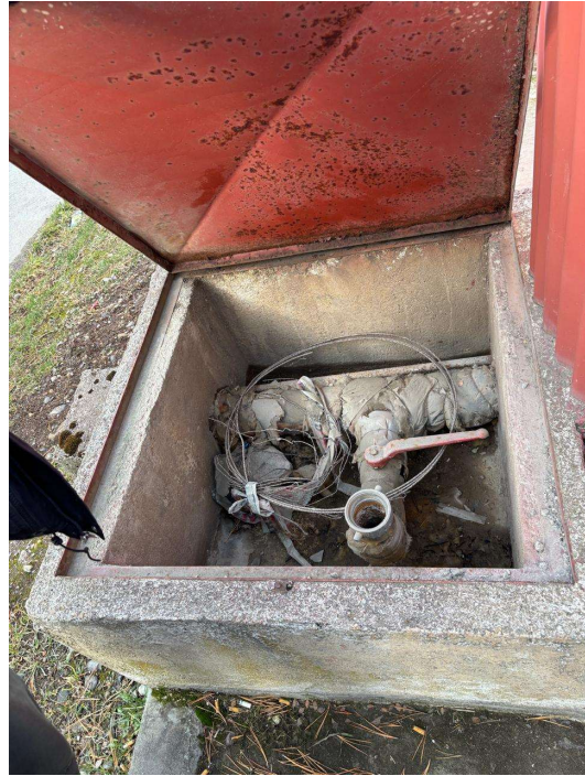
Fotos del sistema de protección contra incendio obsoleto y en desuso:
