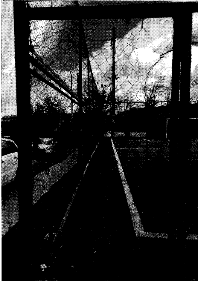
Puerta de acceso principal dañada.
