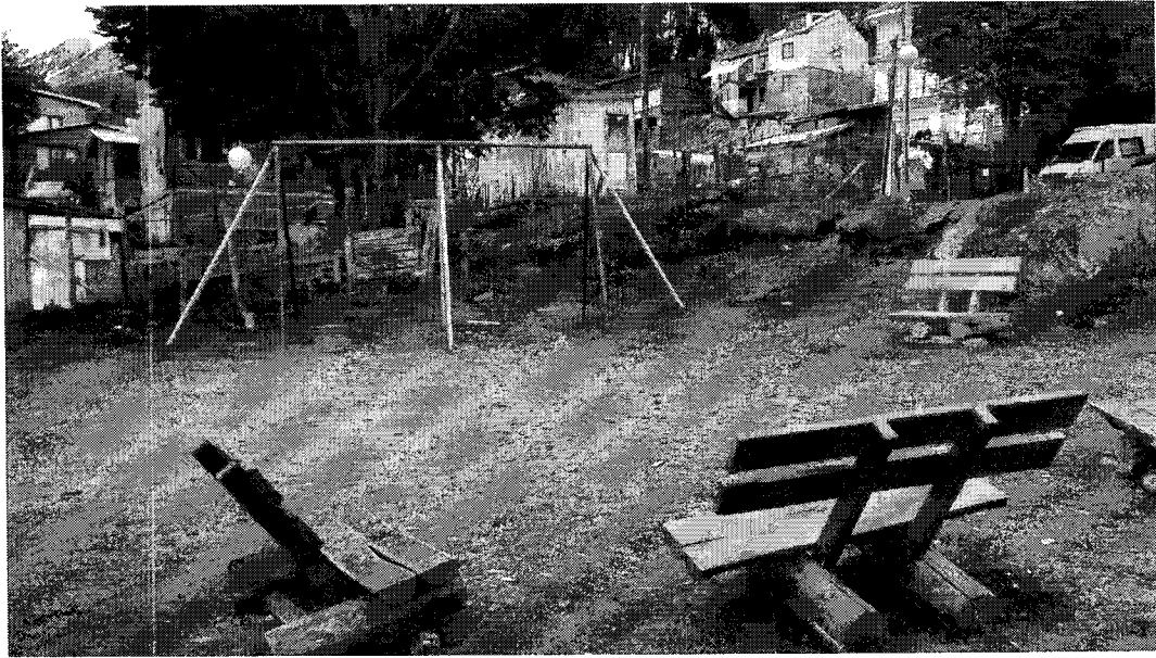
Detalle de la inclinación del terreno afectando a los juegos y los bancos.
