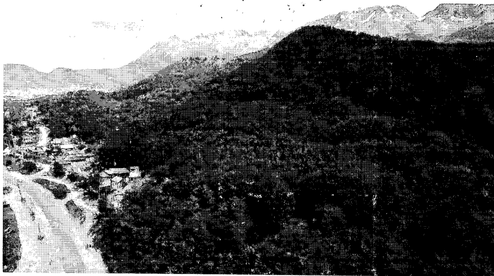
Figura 12: Fotografía del Talud, visto desde la calle Héroes de Malvinas
