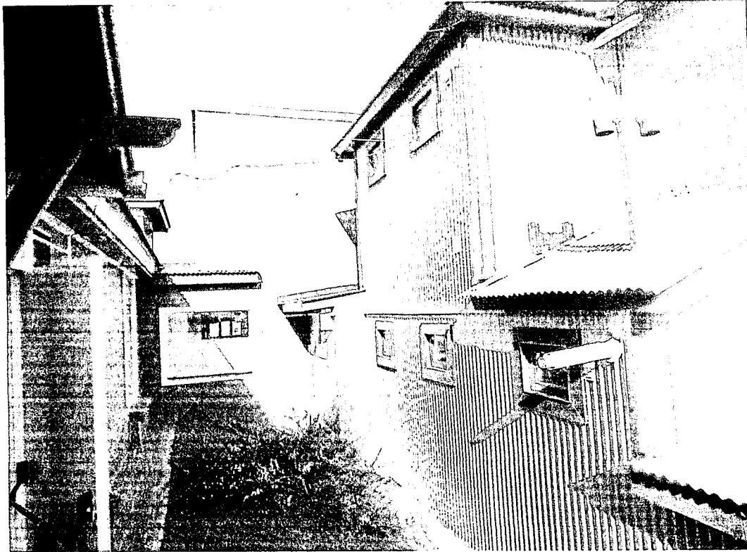
Sector del patio interno donde se produce la ampliación de la sala de espera y redistribución de los baños
