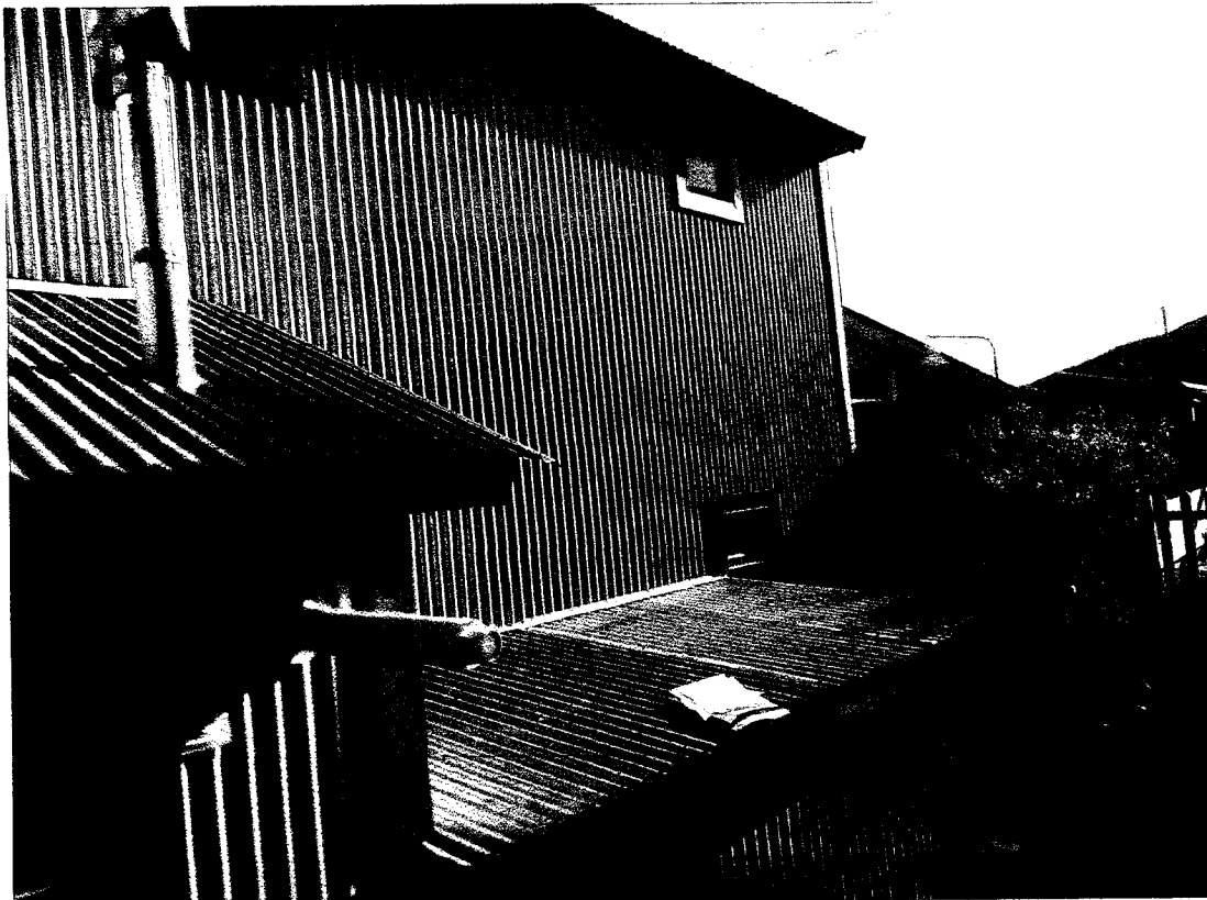
La sala de tanques se llevara a filo de E.D.P. para ganar espacio para baños.
