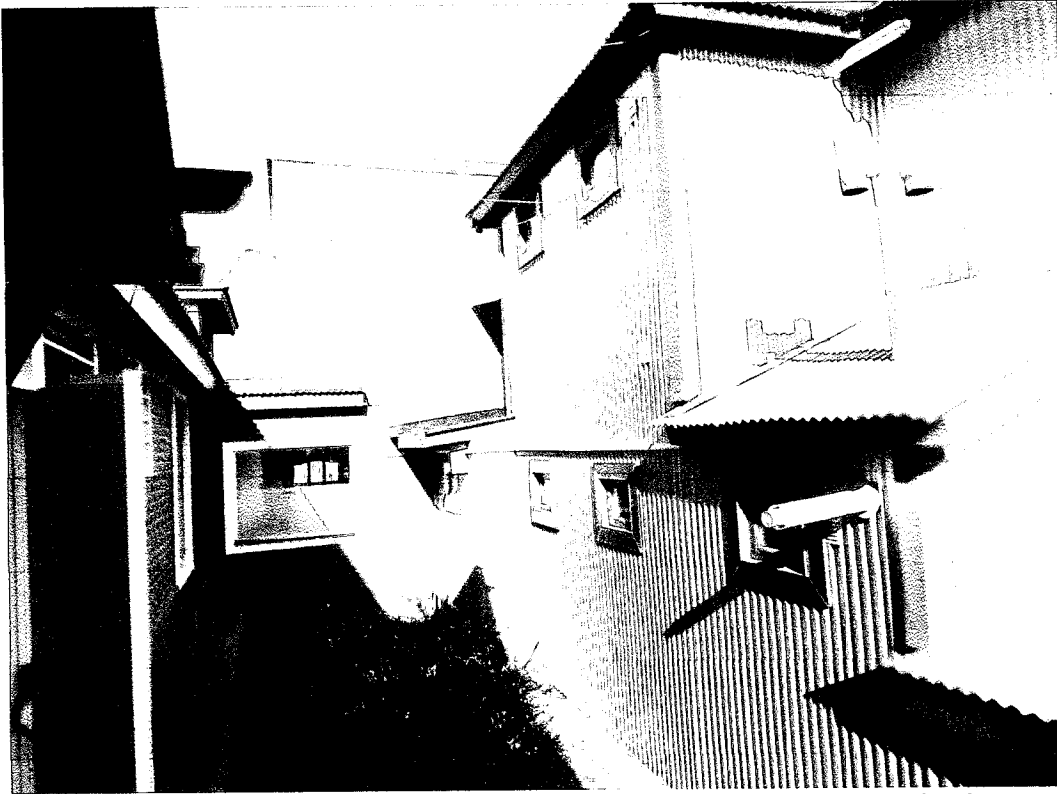
Sector del patio interno donde se produce la ampliación de la sala de espera y redistribución de los baños
