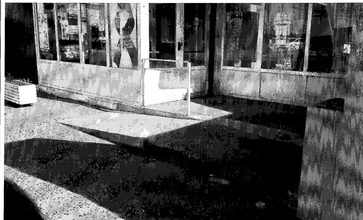
Toma Fotográfica N° 2: Se observa rampa transversal, para salvar peldaño (escalón), no posee pasamanos y señalización.
