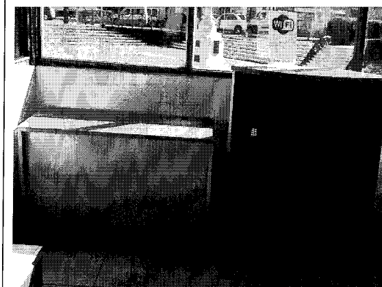
Tomas Fotográficas N° 4 y 5: Se observa la falta de adaptación del mobiliario.
