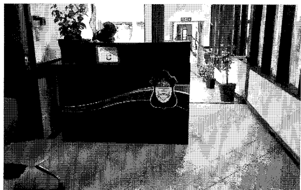
Toma Fotográfica N° 5: Se observa, falta de mostrador adaptado.
