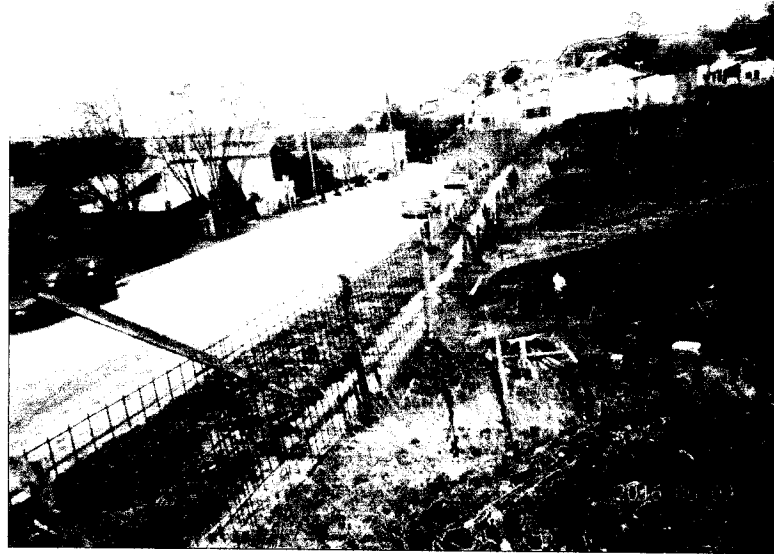
VISTA CALLE CHUBUT
