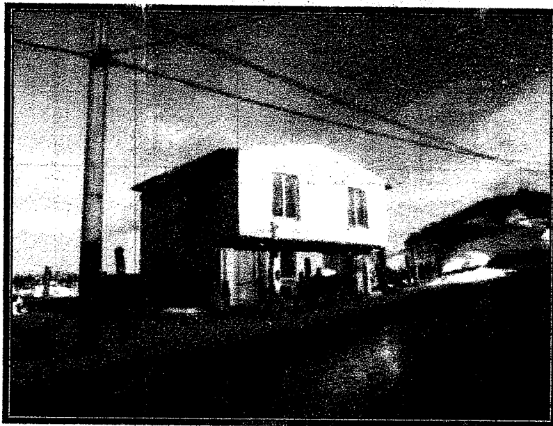
Foto N° 1-21.: Vivienda lindera al predio del ex Basural
