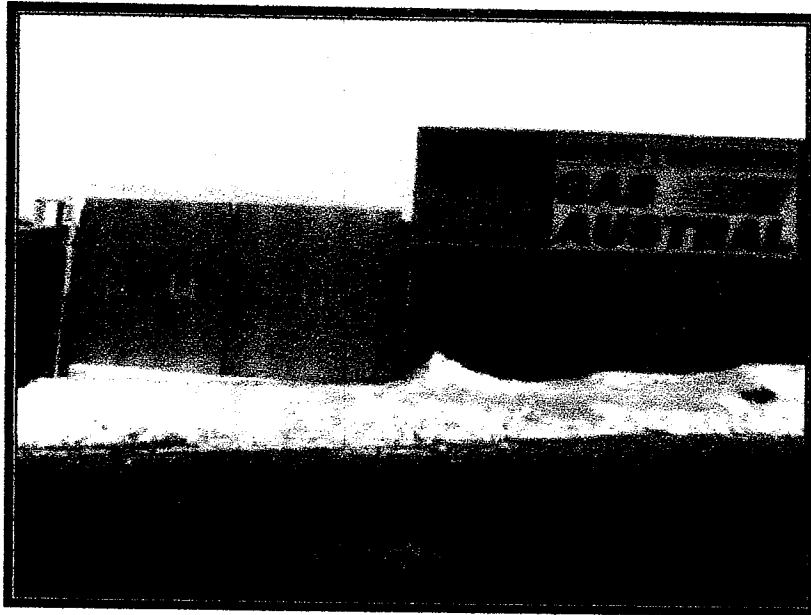
Foto 1-16.: Depósito de Gas Austral
