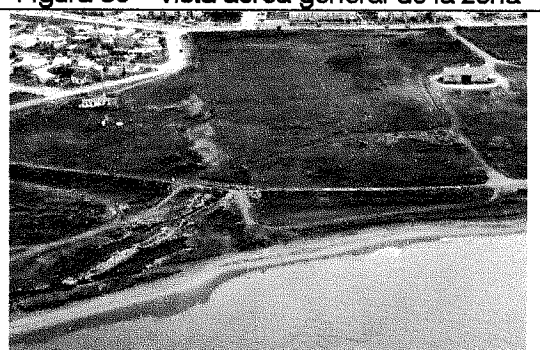
Figura 80 – Vista aérea general de la zona
