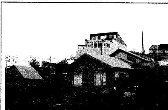
Fuente: Relevamiento propio
