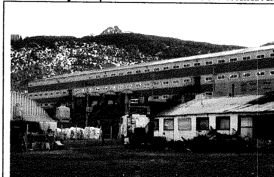
Fuente: Relevamiento propio
