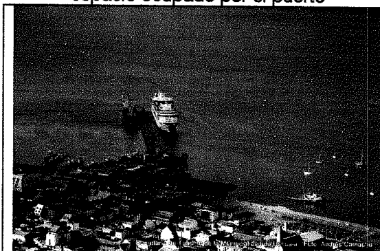
Figura 43 – Vista aérea general del estrecho espacio ocupado por el puerto
