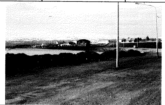
Figura 58 – Estado del borde marítimo sobre la pasarela Luis Pedro Figue
