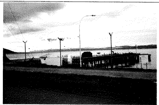
Figura 34 – Muelle de Terminal Orión
