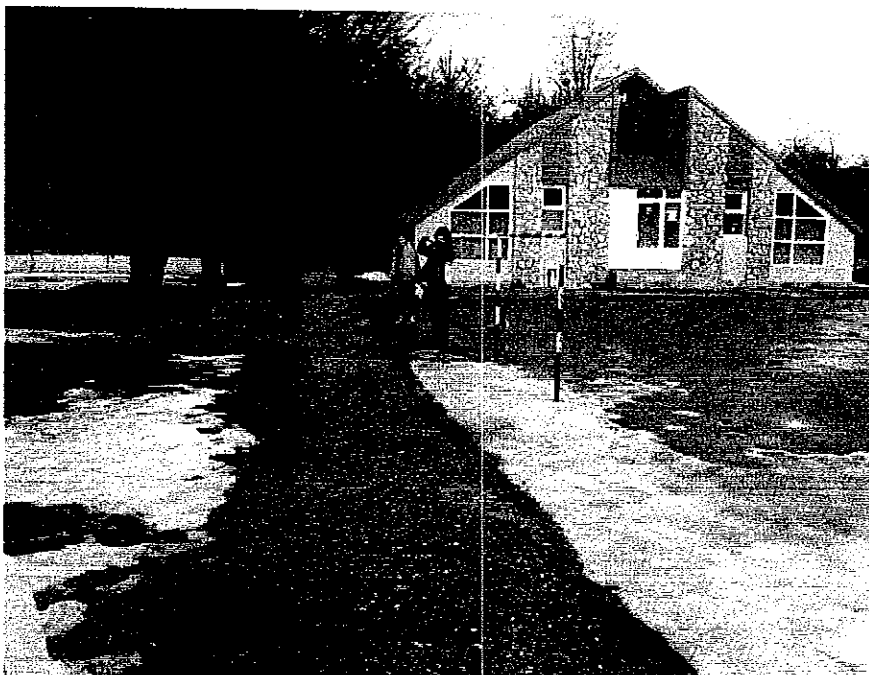
Vista desde sector de acceso al Playón hacia Cabaña a demoler Se observa como fondo el sector del cerco existente. Asimismo vemos la superficie del predio en este tramo consolidado, con poca vegetación y a nivel en una amplia extensión.
