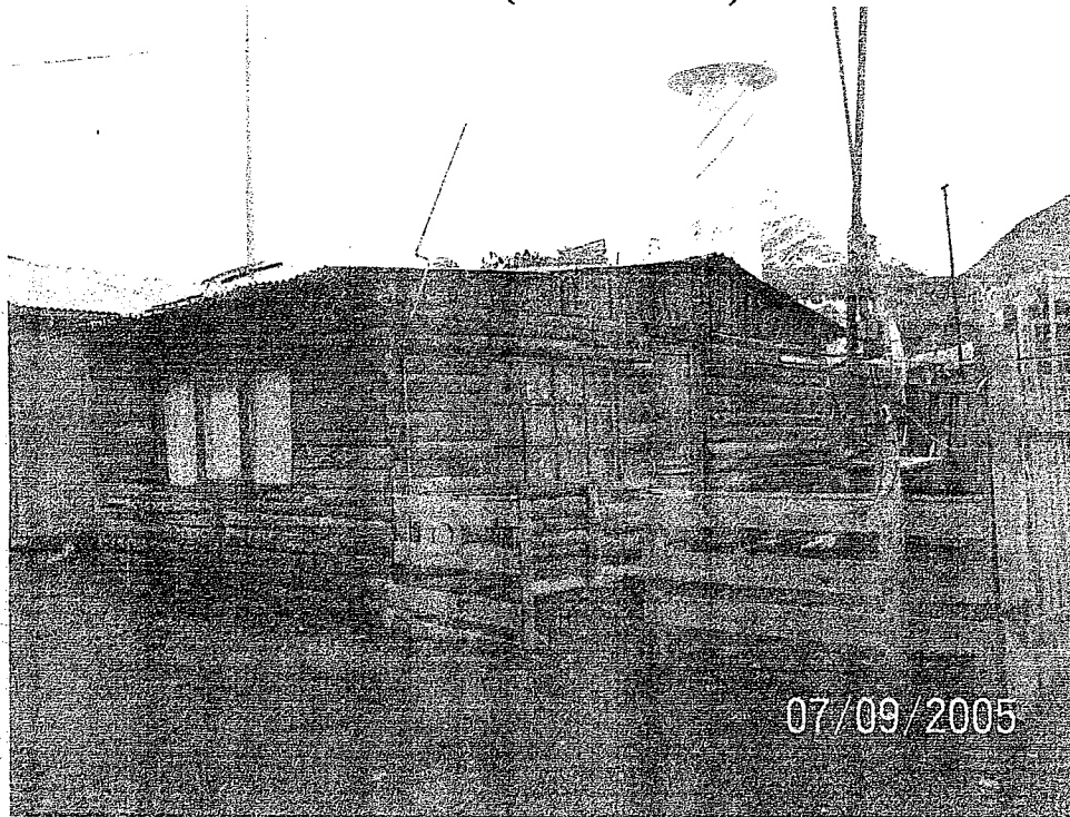
VIVIENDA PRESTADA (casa N° 04 ) - F2
